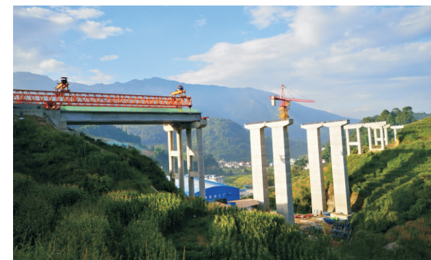
墩柱施工外观质量
