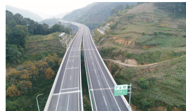
联合3号大桥及联合4号大桥
