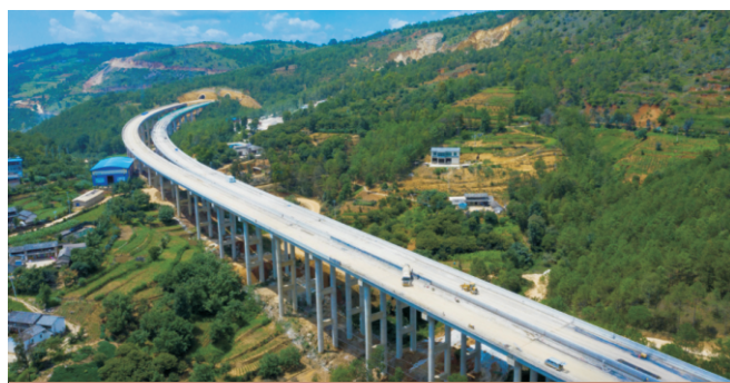
翠岩大桥，建设日期：2020.06.01
