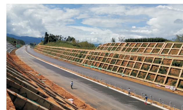
边坡锚杆框格梁防护工程项目施工监理服务,建设日期2019.5.15
