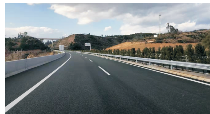
路面工程项目施工监理服务，建设日期2019.12.20
