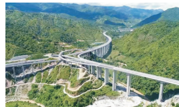
龙岔河特大桥
